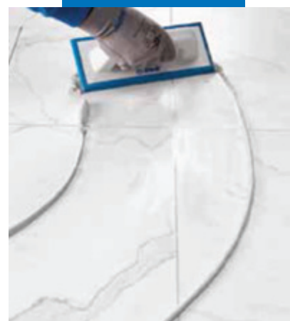
Заполнение швов на полу составом Ultracolor Plus с помощью резинового шпателя
