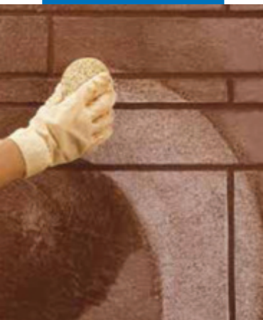
Окончательная очистка плитки с помощью губки
