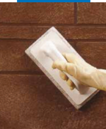
Заполнение швов на стене раствором Ultracolor Plus с помощью резинового шпателя
