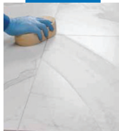
Окончательная очистка плитки губкой
