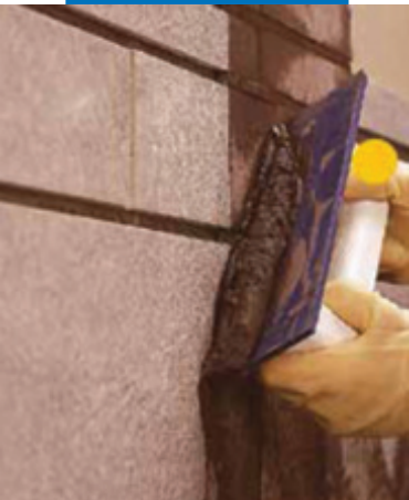
Заполнение швов на полу раствором Ultracolor Plus с помощью ракли с резиновым наконечником
