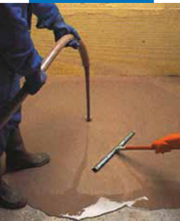
Нанесение Ultraplan насосом с последующей обработкой скребком
