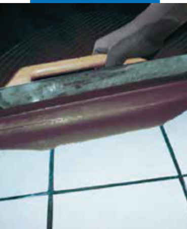
Нанесение Ultraplan металлическим мастерком поверх старых керамических полов после предварительной обработки составом Maپرprim SP
