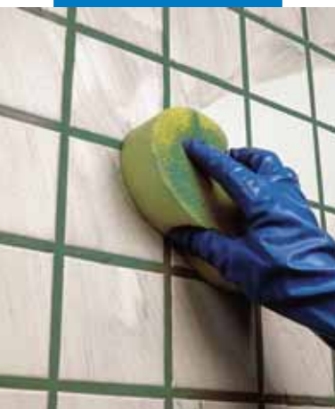
Окончательная очистка плитки с помощью губки
