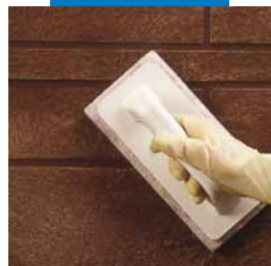
Очистка плитки теркой Scotch-Brite®
