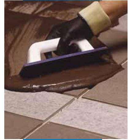
Заполнение швов составом Ultracolor Plus на полу с помощью резинового шпателя
