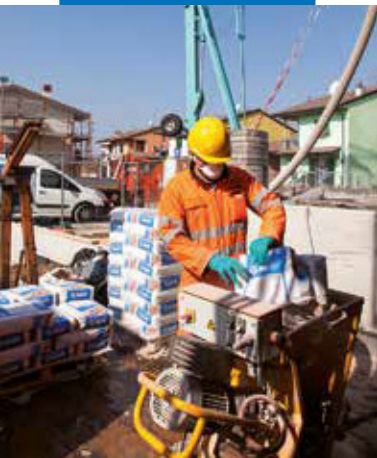
Перемешивание в смесителе Novoplan Maxi R
