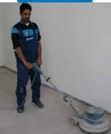
Подготовка основания шлифовальной машиной перед нанесением Ultraplan Eco, детский сад «Мирабэлло», Канту, Италия
