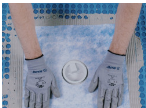
Гидроизоляция дренажных отверстий Drain Vertical/Drain Lateral
