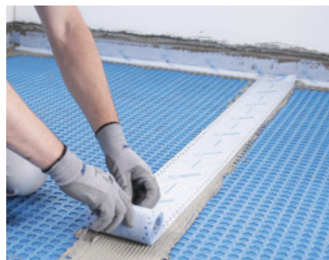
Гидроизоляция швов между листами с помощью Mapeband Easy на Mapeguard WP Adhesive
