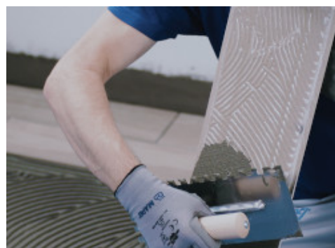
Укладка керамической плитки или камня на подходящий клей MAPEI класса не ниже C2
