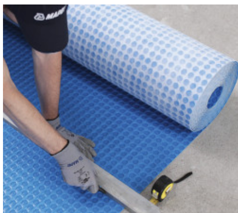
Резка Mapeguard UM 35
