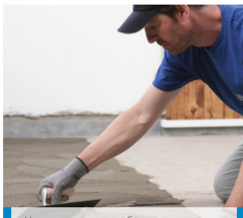
Нанесение клея зубчатым шпателем №5
