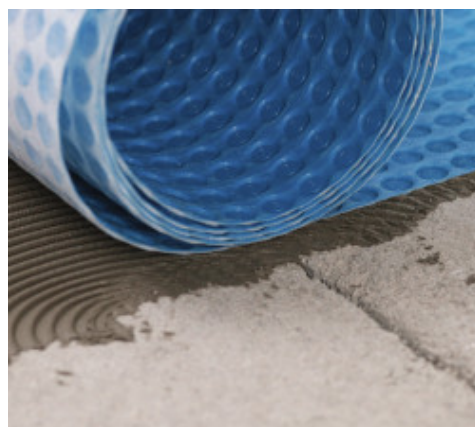
Укладка Mapeguard UM 35
